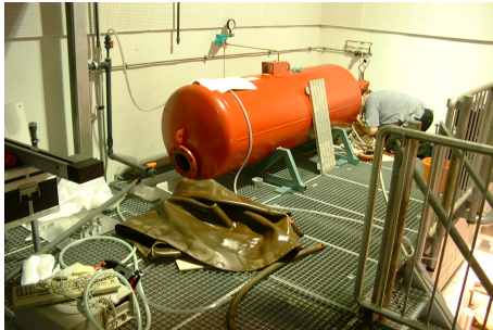
Figure: Réservoir de 1000 L en réparation
